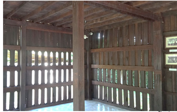
ภาพที่ 11 (ภาพถ่าย) และ ภาพที่ 12 (ภาพขาว) ลักษณะของหลังคาแบบมะนิลา และหน้าต่างแบบฝาไหลในเรือนพื้นถิ่น
