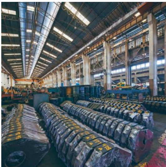
ภาพที่ 16 และภาพที่ 17 สภาพภายในอาคารโรงรถจักร 1 (โรงซ่อมรถจักรดีเซลไฮดรอลิก) ลักษณะเป็นอาคารชั้นเดียว ผังของอาคารเป็น รูปสี่เหลี่ยมผืนผ้าแคบยาว ใช้โครงสร้างระบบเสาคานคอนกรีตเสริมเหล็กขนาดใหญ่ หลังคาเป็นโครงเหล็กถัก (Truss) (การรถไฟแห่งประเทศไทย, 2564)
