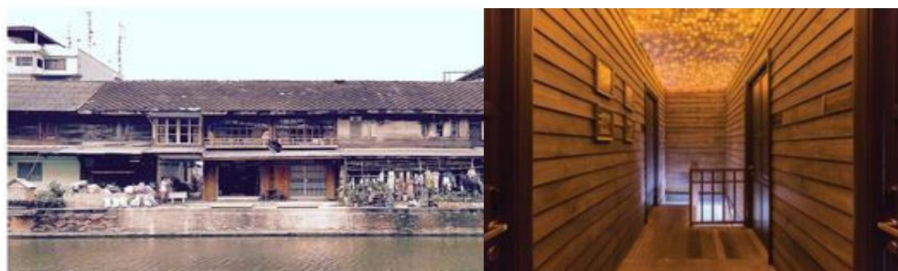
ภาพที่ 5 รูปด้านอาคาร Canale Hostel และบรรยากาศภายในโถงทางเดินชั้น 2 Canale Hostel (ธนากร โมกษะสมิต และต้นข้าว ปาณินท์, 2561)
