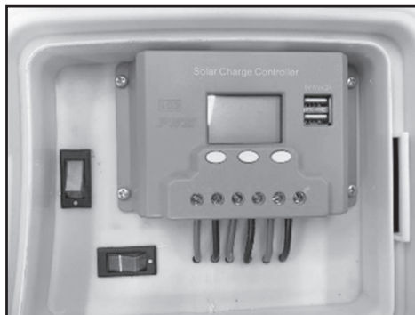
ภาพที่ 5 การติดตั้งโซล่าชาร์จเจอร์ คอนโทรลเลอร์พร้อมสวิตช์
