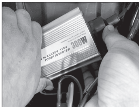
ภาพที่ 9 การติดตั้งชุดอินเวอร์เตอร์
