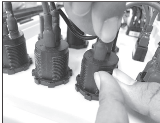
ภาพที่ 11 การต่อพ่วงสายไฟฟ้า
