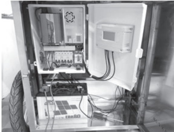
ภาพที่ 7 การสร้างและติดตั้งอุปกรณ์ไฟฟ้าและระบบควบคุม
