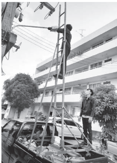
ภาพที่ 9 อุปกรณ์ช่วยจับยึดบันไดบนรถกระบะ
