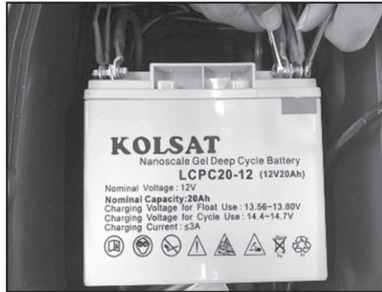
ภาพที่ 10 การติดตั้งแบตเตอรี่และการพ่วงแบตเตอรี่
